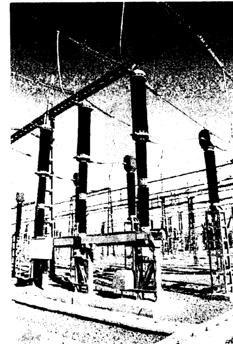
Fig. 4.9. Interruptor de SF 6 de 220 KV.
